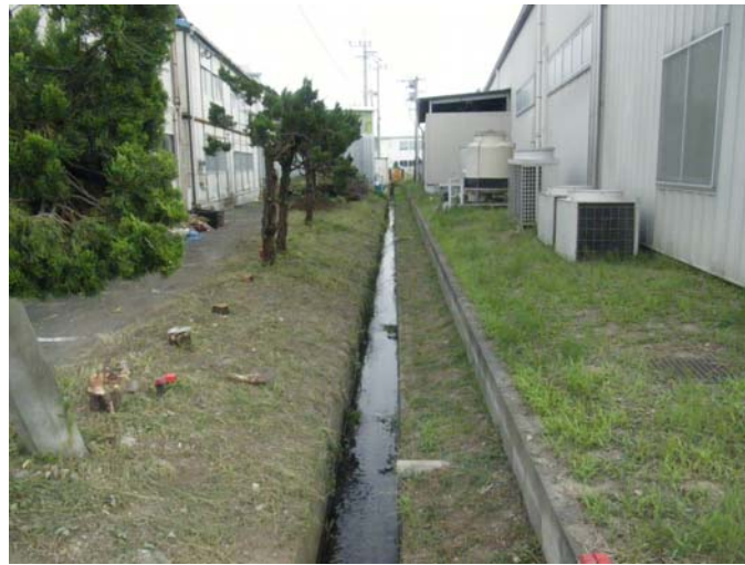
(除草作業完了)
