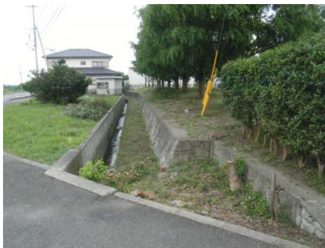
(除草作業完了)
