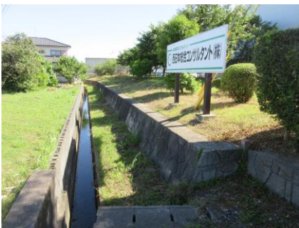
(↑上和泉水路 草刈り清掃完了)
