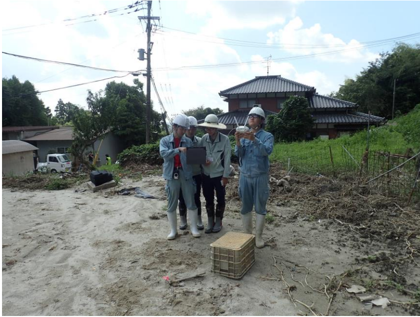
災害現場・ドローン測量見学
