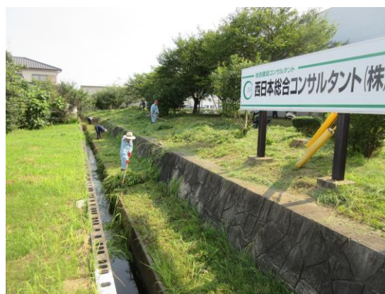
社屋東側・上和泉水路草刈り作業
