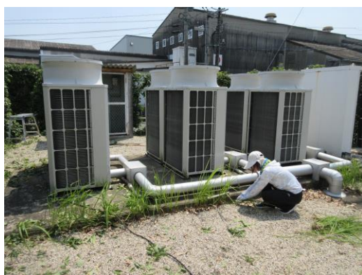
空調設備付近・草刈り
