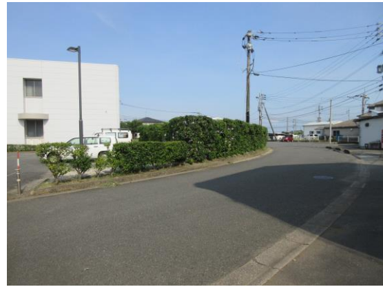
社屋西側・変電所付近 作業終了後
