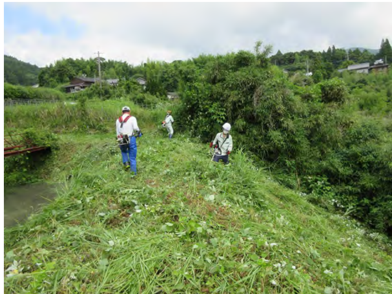
(↑ 農業用ため池堤防の草刈り)
